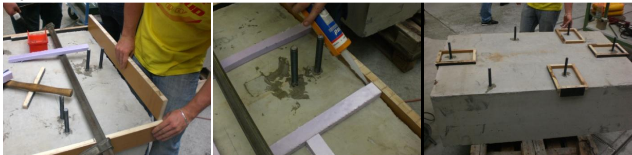
Abb.35: Anbringung der Schalung und des Silikons
