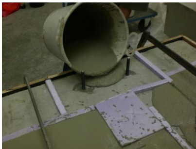
Abb.37: Eingießen des Vergussmörtel
